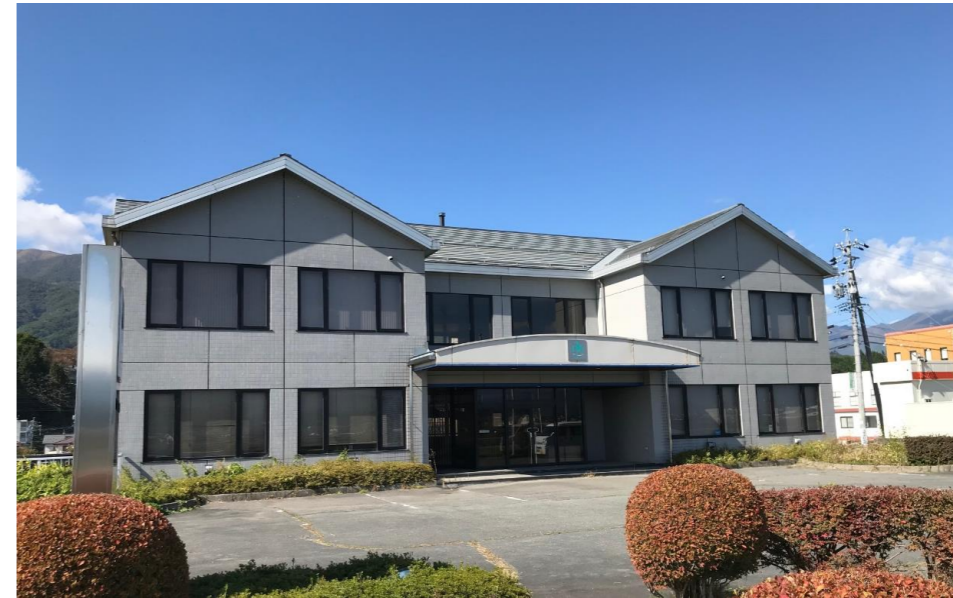
○東側国道153号より社屋 (2025年9月末日まで解体工事)
